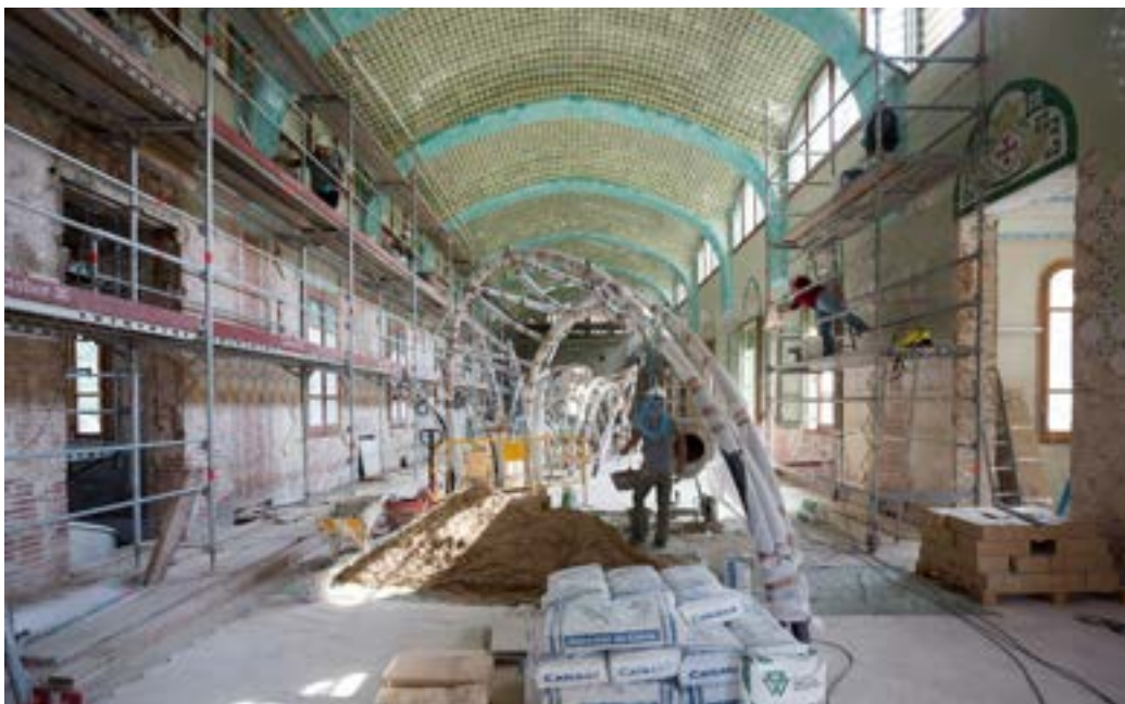
Procés de reforma del Pavelló de Sant Salvador, on avui s'ubica l'espai expositiu (Robert Ramos© / Arxiu FHSCSP).
