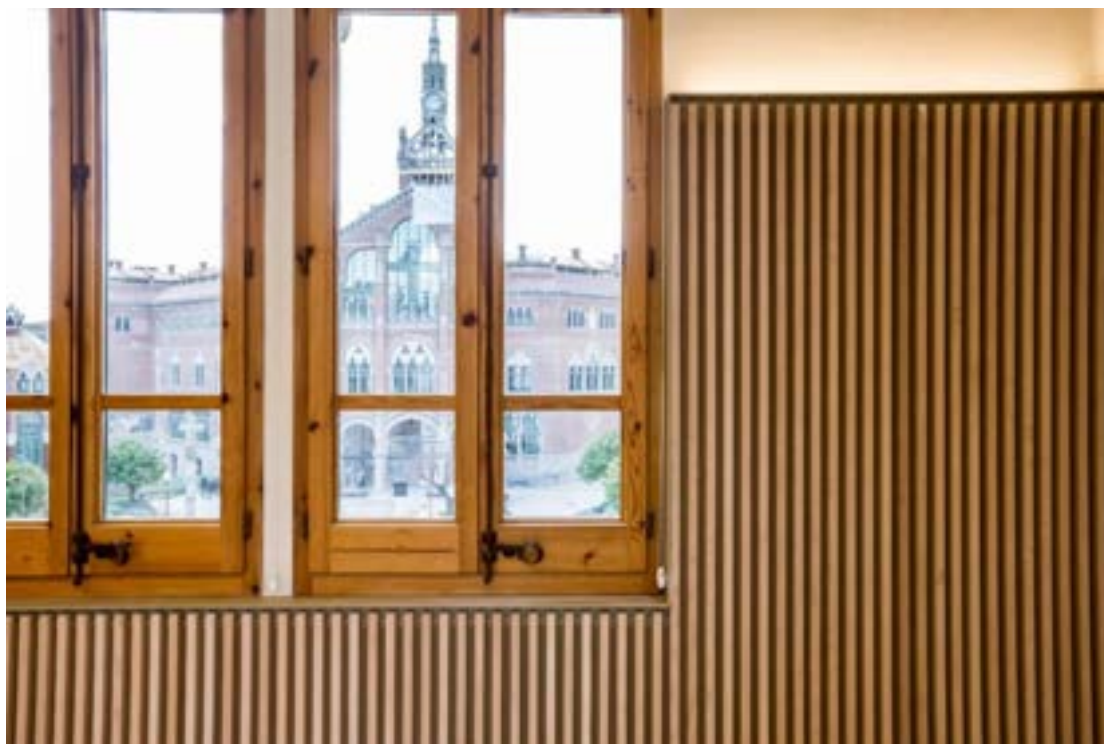
Les parets d'alguns espais es van recobrir amb costelles de fusta per tal d'amagar les diferents instal·lacions i per una qüestió d'acústica. A la fotografia hi veiem la paret d'una de les sales de l'antiga Casa d'Operacions (Robert Ramos© / Arxiu FHSCSP).
