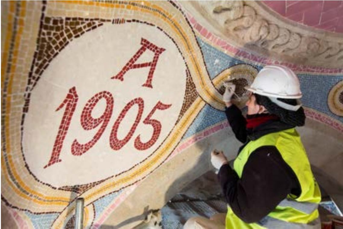
Les restauradores van repassar, un a un, tots els mosaics que guareixen el recinte. En aquest cas, el treball s'està fent sobre una de les voltes del vestíbul del Pavelló de l'Administració (Robert Ramos© / Arixu FHSCSP).
